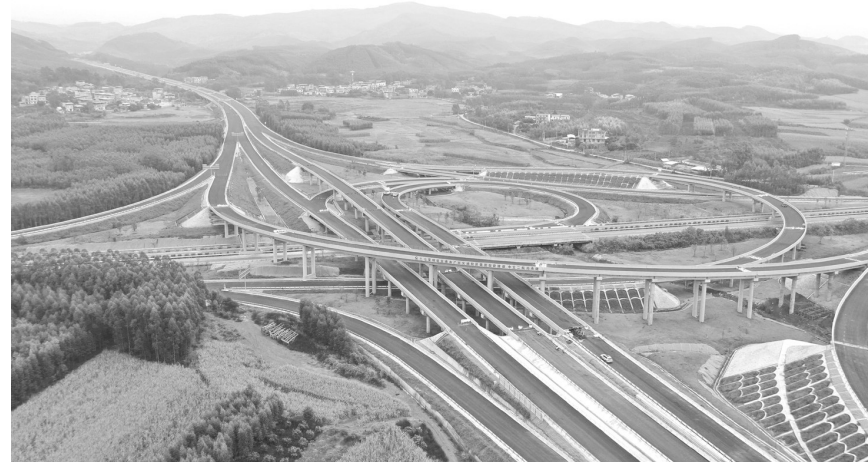
▲11月29日,在平武高速(平南—武宣)武宣段七星互通施工现场,工人正在进行路容路貌清理维护等收尾工作,全力冲刺2022年底(武宣段)通车目标。
