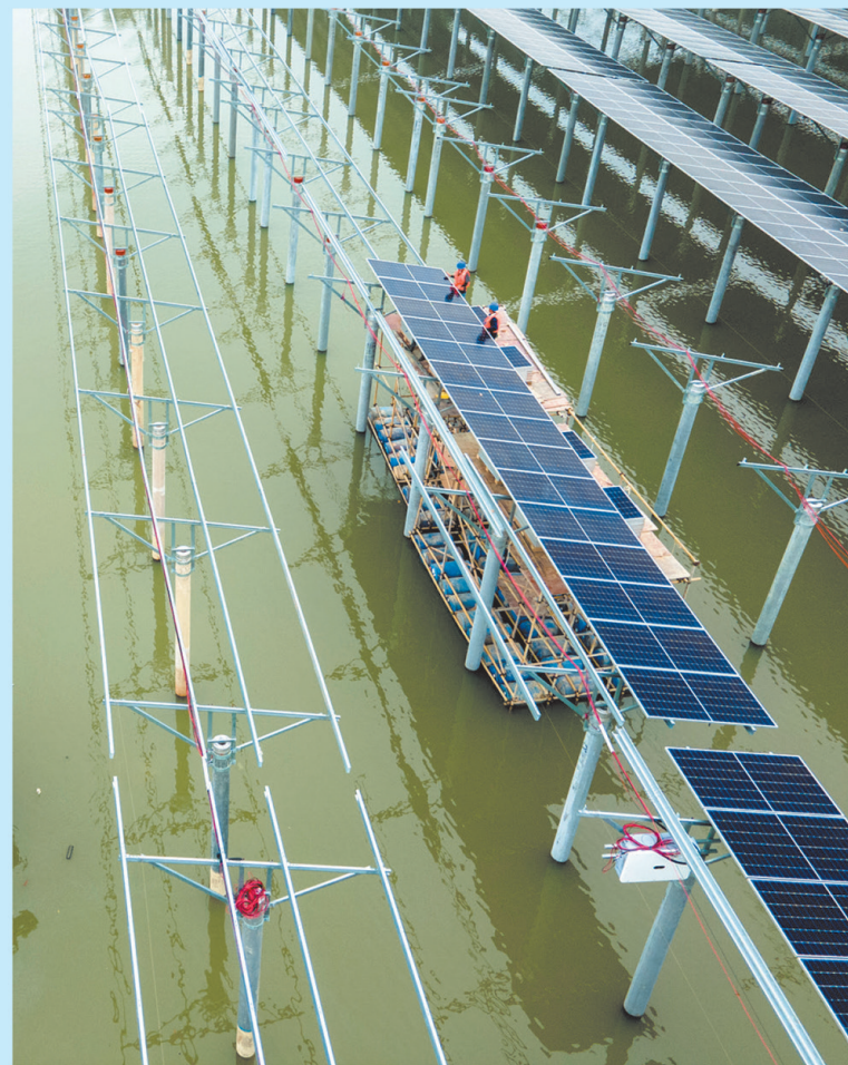
去年3月,项目施工人员正在铺设光伏板。
