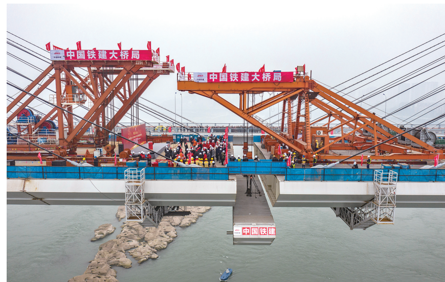
▲这是李家沱长江复线桥合龙施工现场(1月12日摄,无人机照片)。当日,由中国铁建大桥局承建的重庆轨道交通18号线关键控制性工程——李家沱长江复线桥成功合龙。李家沱长江复线桥全长约1306米,于现有的李家沱长江大桥上游约52米处平行跨越长江。 新华社发
