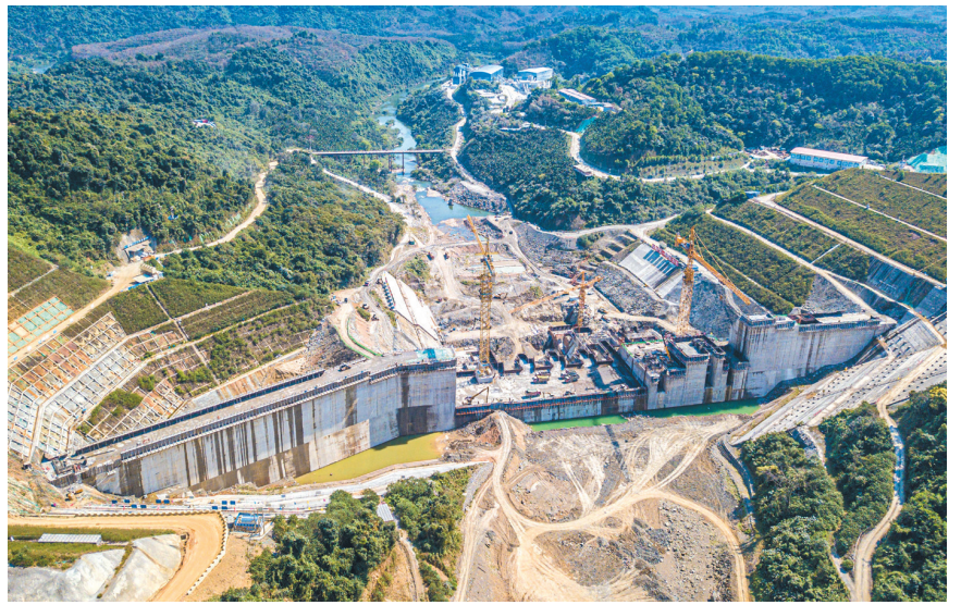
▲这是2月12日拍摄的迈湾水利枢纽工程(无人机照片)。
