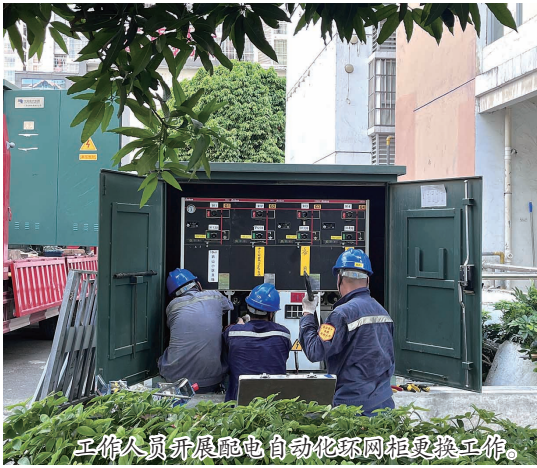
工作人员拆除配电自动化环网柜受电工作。
