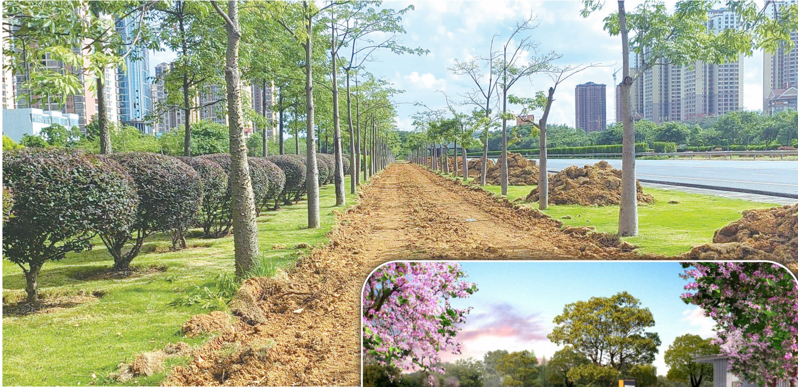
▲项目已完成场地清表工作,正在开展苗木移植作业。
