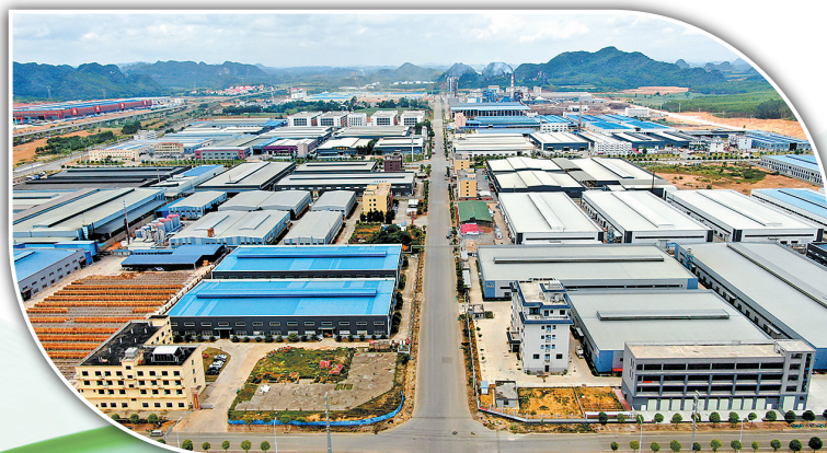
▲崇左·龙赞东盟国际林业循环经济产业园区标准厂房聚集众多企业。
