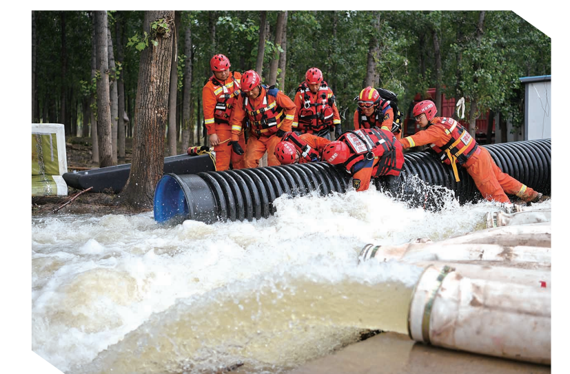
▲8月6日,在河北省涿州市刁窝镇东张村,唐山消防救援支队队员正在进行排涝作业。当日,随着河北省涿州市部分受灾地区水势逐渐消退,当地居民、志愿者和消防救援人员在涿州市多个村庄开展清淤、消杀、排涝等灾后修复工作,争取将损失降到最低。新华社发
