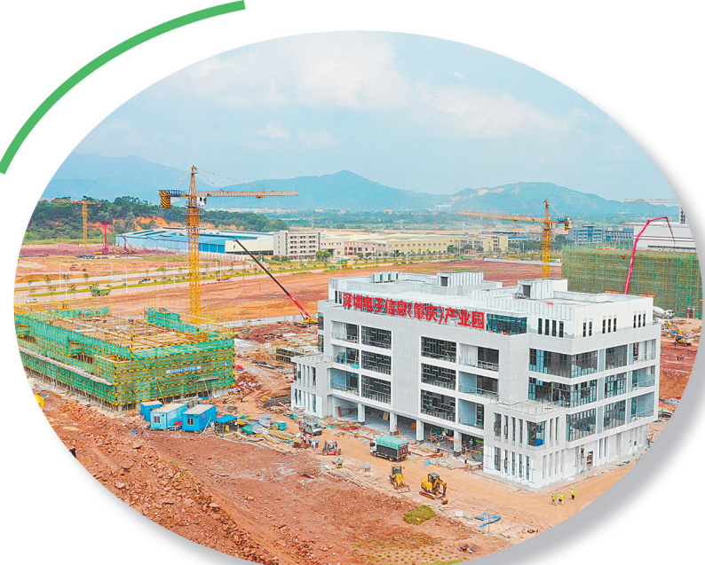
广东省(肇庆)大型产业集聚区富溪片区正在加紧施工。
