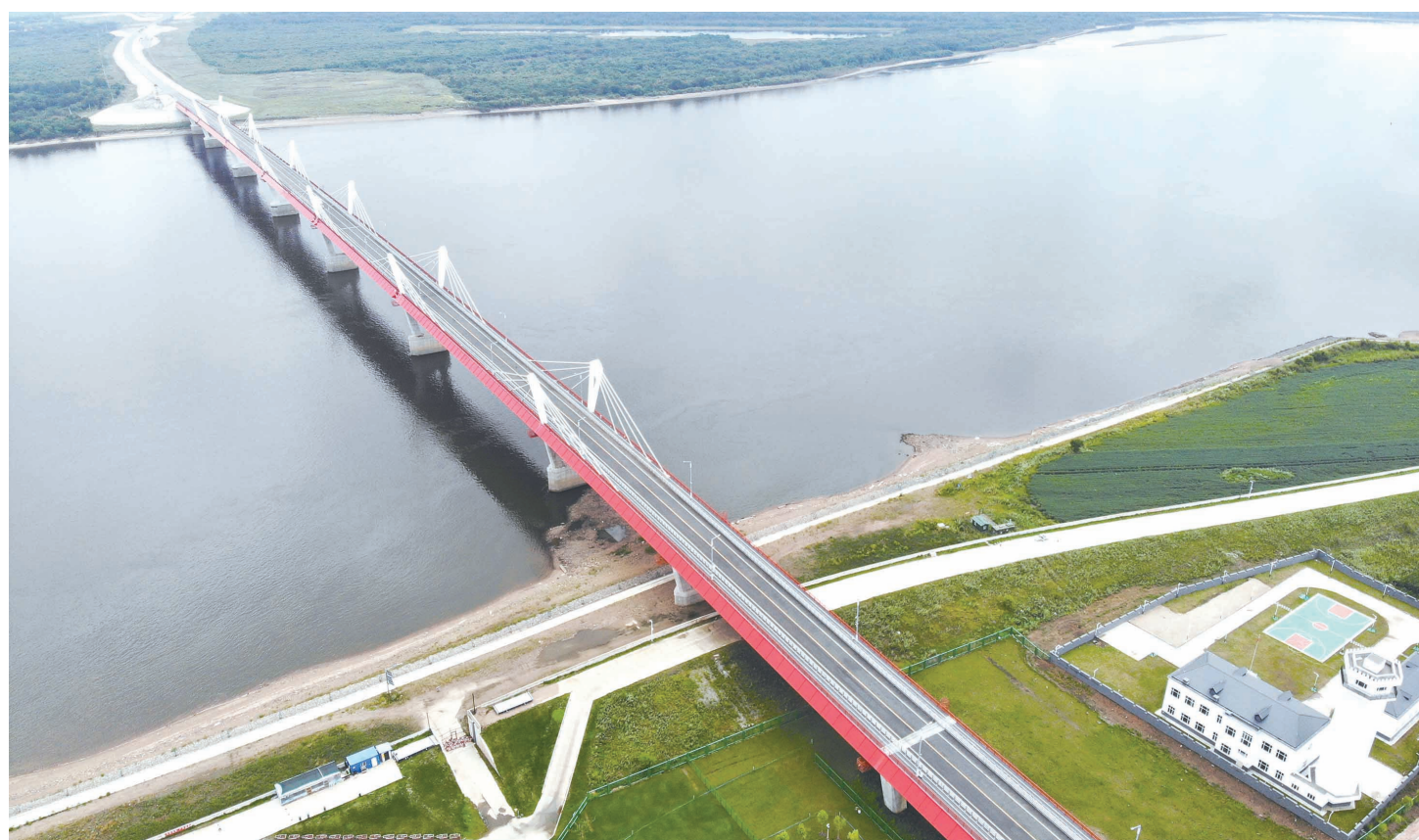
▲这是8月11日在中国黑河一侧拍摄的黑河—布拉戈维申斯克公路桥(无人机照片)。中国东北边城黑河与俄罗斯布拉戈维申斯克隔黑龙江相望,被称为“中俄双子城”。2022年6月10日,中俄首座跨黑龙江公路大桥黑河—布拉戈维申斯克公路桥正式通车,在中国东北地区和俄罗斯远东地区之间开辟新的国际运输通道,成为中俄跨境互联互通建设的标志。一座大桥让两座边城“连”在一起。两座城市互通有无,获得了巨大的发展空间。新华社发
