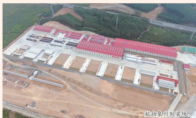
航拍象州制梁场。
