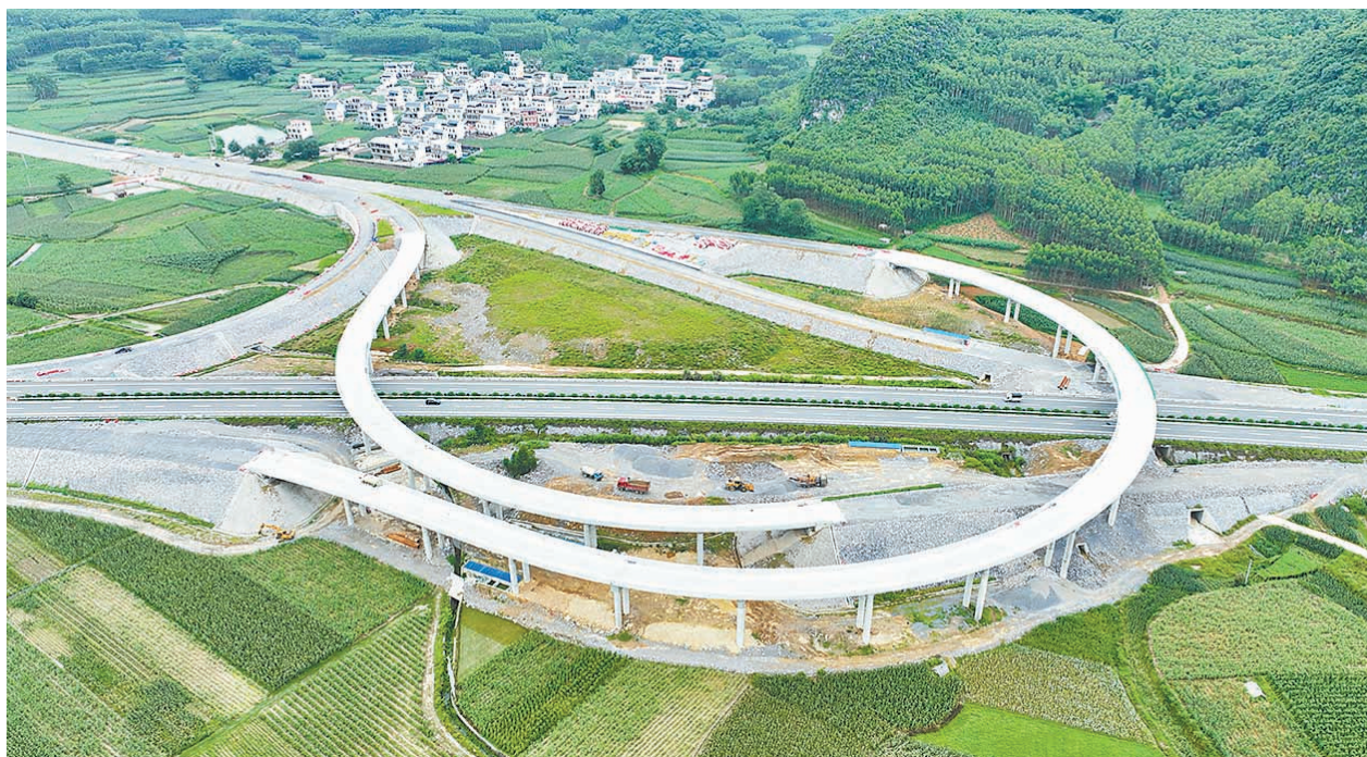
▲近日，武忻高速忻城段路基施工已基本完成，正全力推进路面施工。据悉，武忻高速全长118.744公里，总投资186.12亿元，途经武宣县、兴宾区、合山市、忻城县，是自治区统筹推进的重大交通基础设施建设项目。
