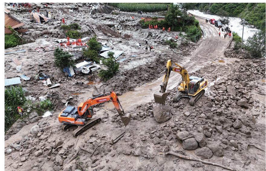
▲8月4日，在四川甘孜州康定市姑咱镇日地村，救援人员操作机械疏通国道318线(无人机照片)。
