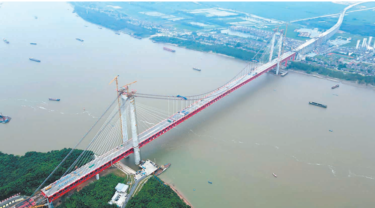
▲8月27日拍摄的G3(京台高速)铜陵长江公铁大桥合龙现场(无人机照片)。
