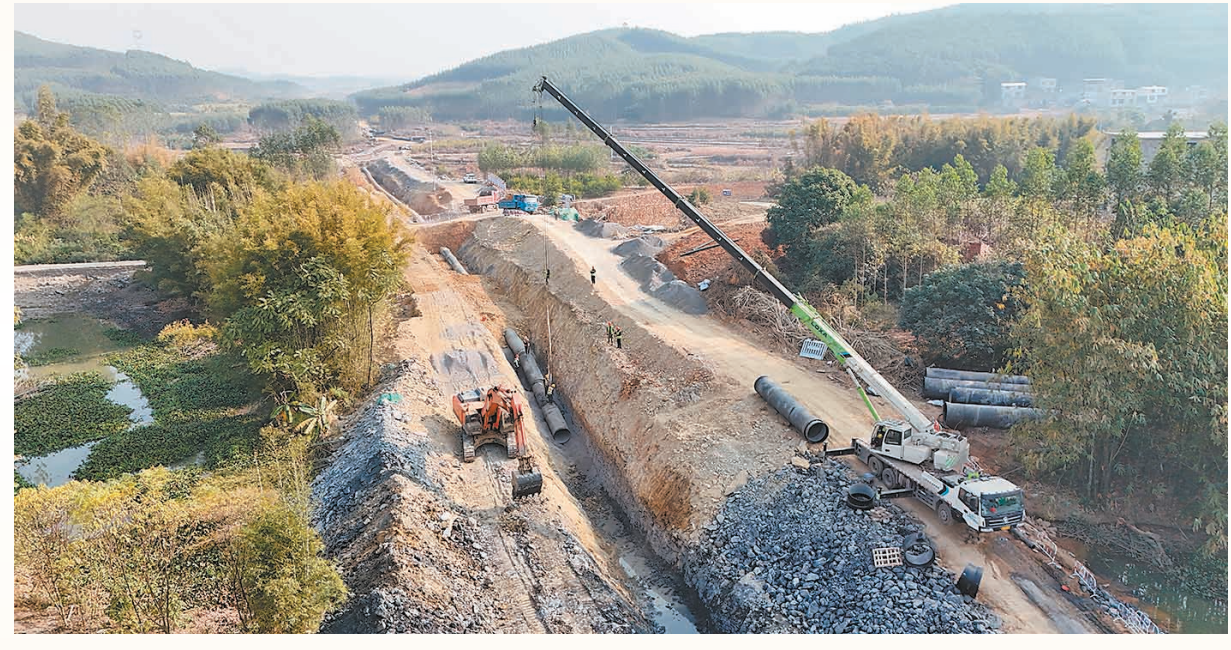
▲来宾市下六甲灌区工程游龙枢纽施工现场。
