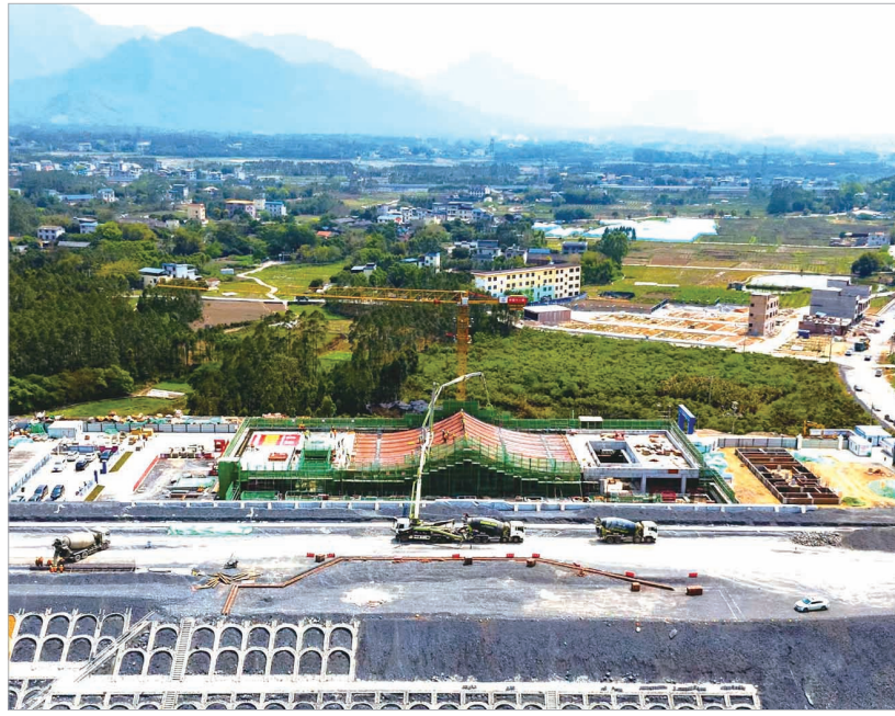
▲航拍柳梧铁路东乡站房项目施工现场。(韦的岩 龙会师 摄)
