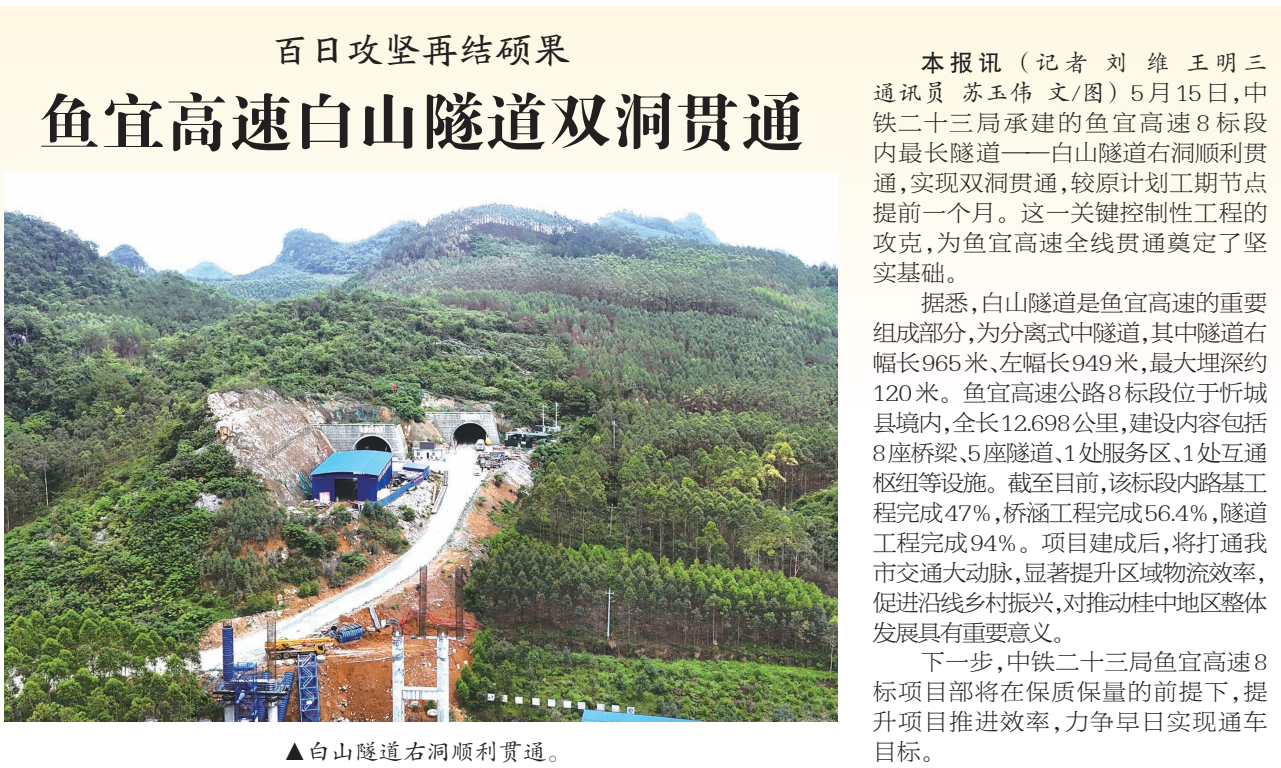
白山隧道右洞顺利贯通。
