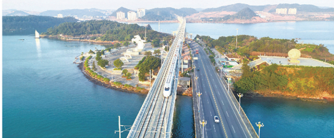
动车驶过防城港西湾跨海大桥
