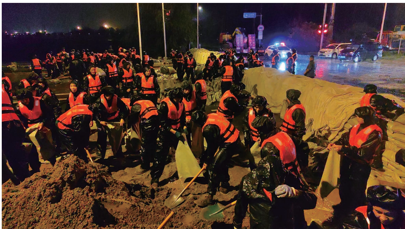
▲7月28日,武警北京总队千余名官兵在密云区宁村新桥构筑堤坝。近日,华东、华北、东北等地持续遭遇强降雨,引发洪涝和地质灾害,造成重大人员伤亡和财产损失。灾情就是命令,解放军和武警部队官兵、民兵迅速出动,投入防汛抢险救灾任务。 新华社发
