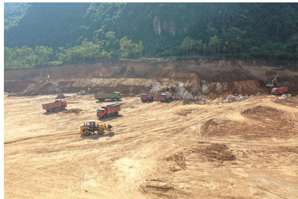
▲广西佳山新材料项目建设现场(航拍)。
