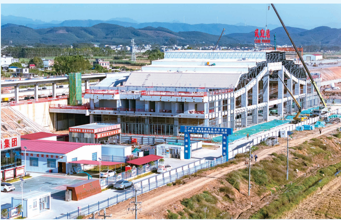
▲武宣站站房金属屋面施工现场。（黄品青 摄）
