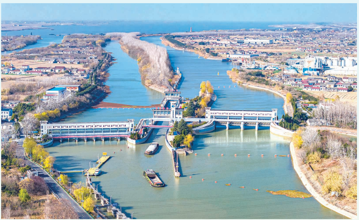
▲12月21日在江苏省扬州市江都区拍摄的南水北调东线一期工程运盐闸、邵仙套闸、邵仙闸洞（无人机照片）。新华社发
