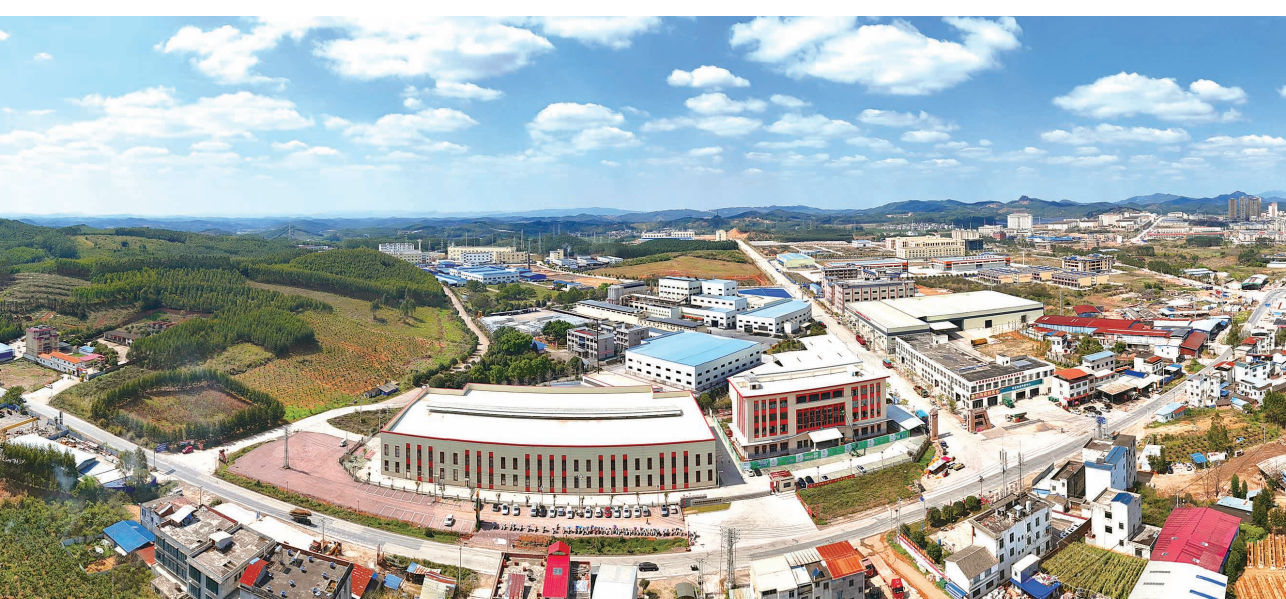
▲广西宏瑶生物科技有限公司产业园项目。（航拍）
