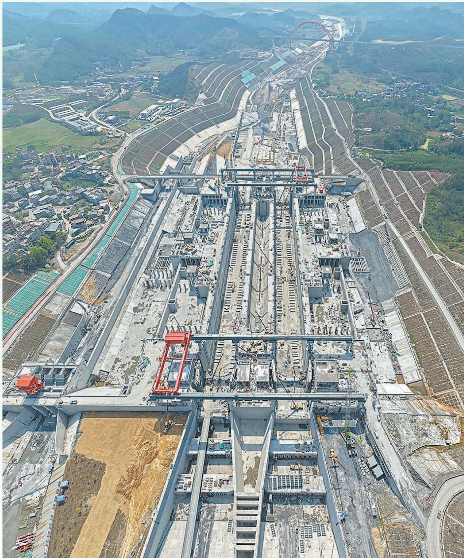
▲这是2026年3月5日拍摄的广西平陆运河马道枢纽建设现场(无人机照片)。 新华社发
